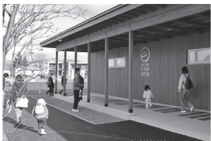
くるみ保育園新園舎
