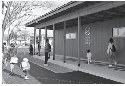
くるみ保育園新園舎
