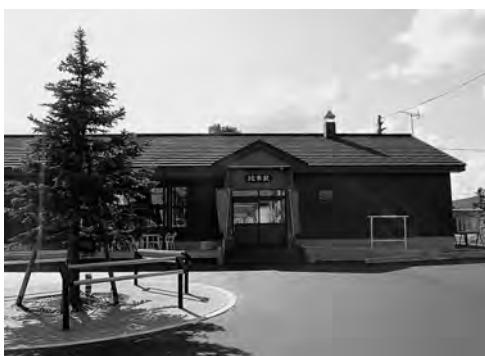
新しい比布駅舎と交流スペースの駅前広場
